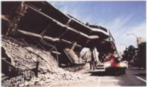
写真3 高架道路の崩壊(兵庫県南部地震)
