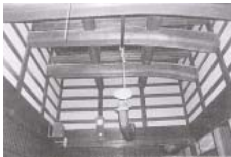
大きな吹き抜け空間を固める「サシモン」造り [ 石川県・鈴木有による ]
