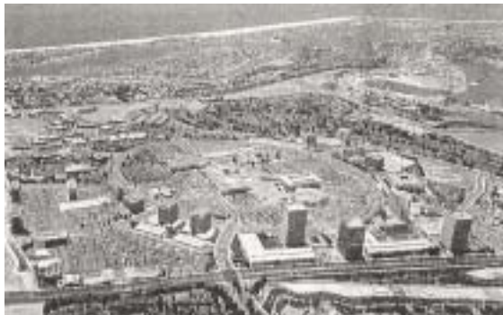
環状を基調とした街並み (米国：ニューポートビーチ)
