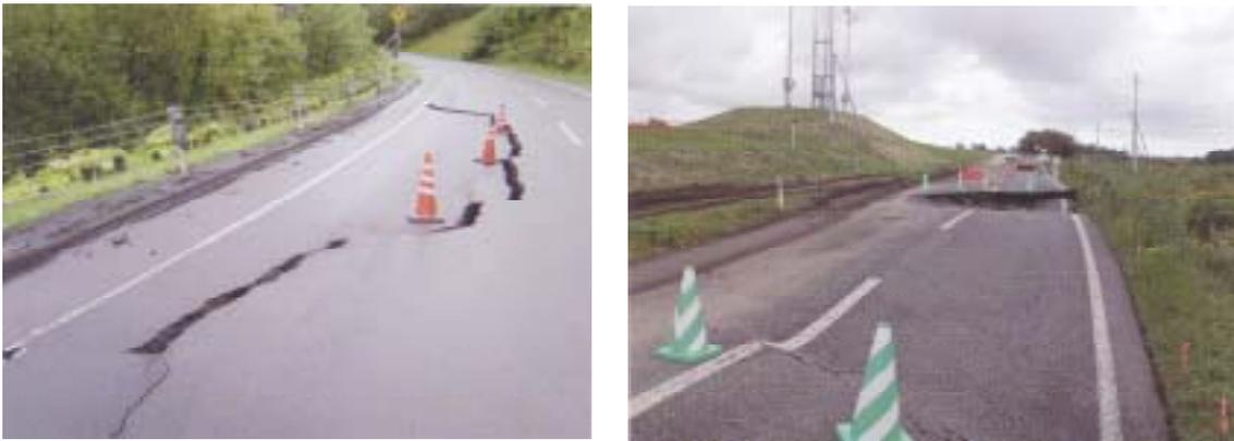
写真 十勝沖地震(2003年9月26日)の際の道路被害、北海道開発局・北海道開発土木研究所提供
