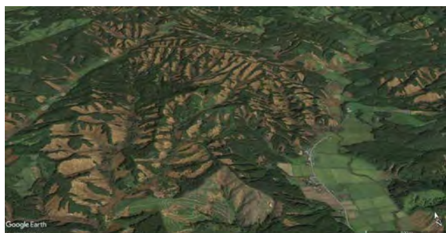
写真 1 2018 年 9 月厚真町高丘地区 斜面の土色部分が山腹崩壊箇所 Google Earth より
